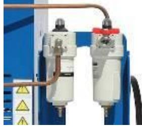
Сжатый воздух обычно содержит вредные примеси в твердом, жидким или парообразном состоянии, которые могут привести к преждевременному износу подключенное оборудование или его компоненты. Для тонкой очистки сжатого воздуха мы применяем **фильтры на основе ультратонкого стекловолокна**.
